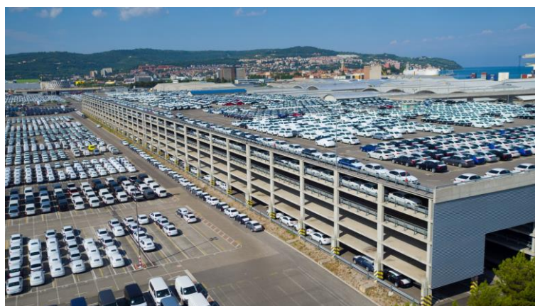
Odprte skladiščne površine in garažna hiša
